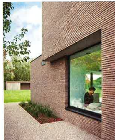
beige metselwerk, gekleurd kozijn.
