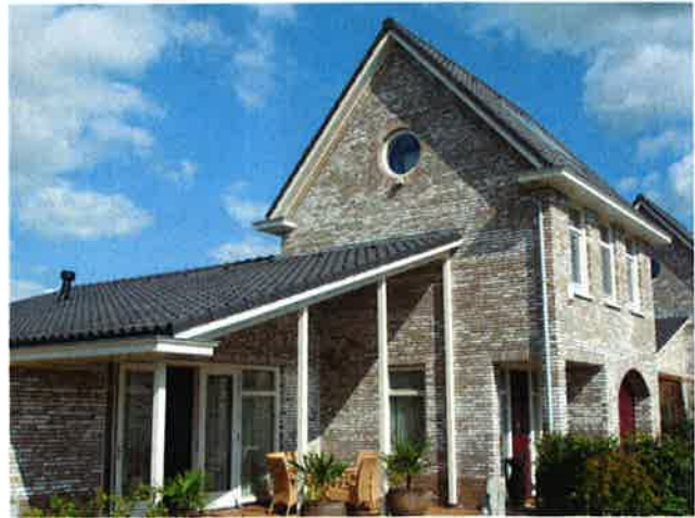
metselwerk in grijs tint.
