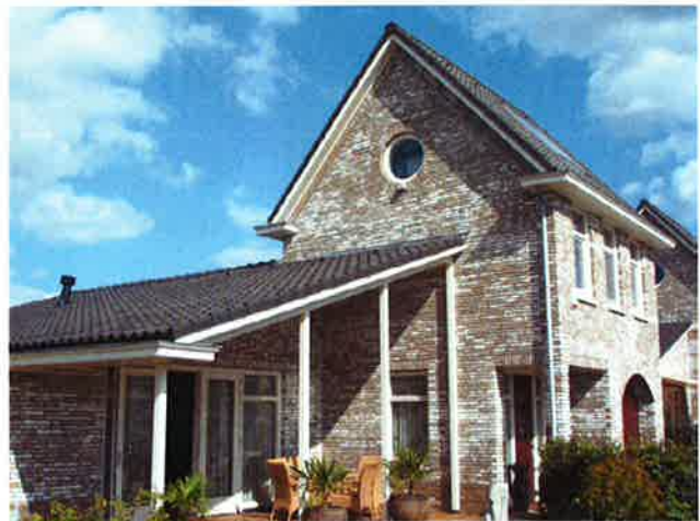
metselwerk in grijstint.
